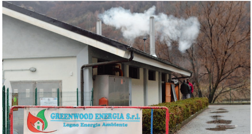
L'impianto a cippato mitiga i rincari dell'energia termica. Rimane fuori controllo la bolletta elettrica. Fotografica Gariglio
